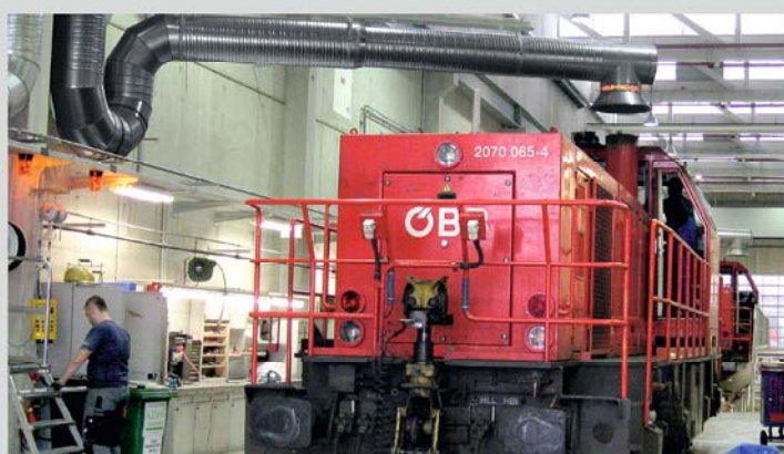
Extraction sur locomotives diesel via bras latéral rotatif.
